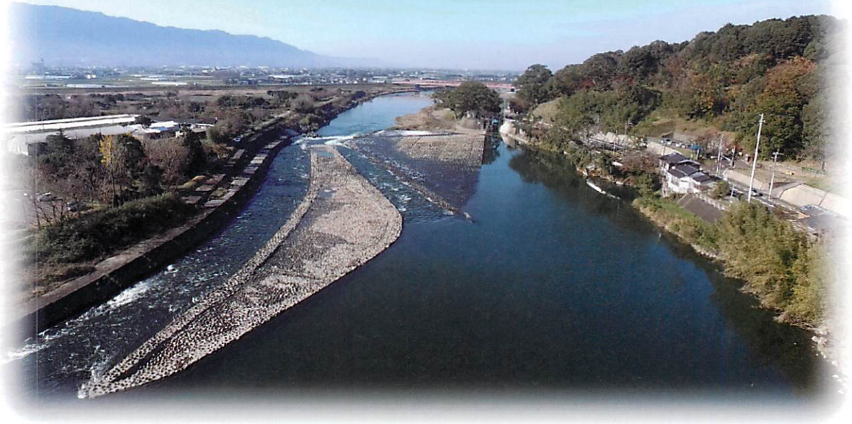
筑後川 山田堰
